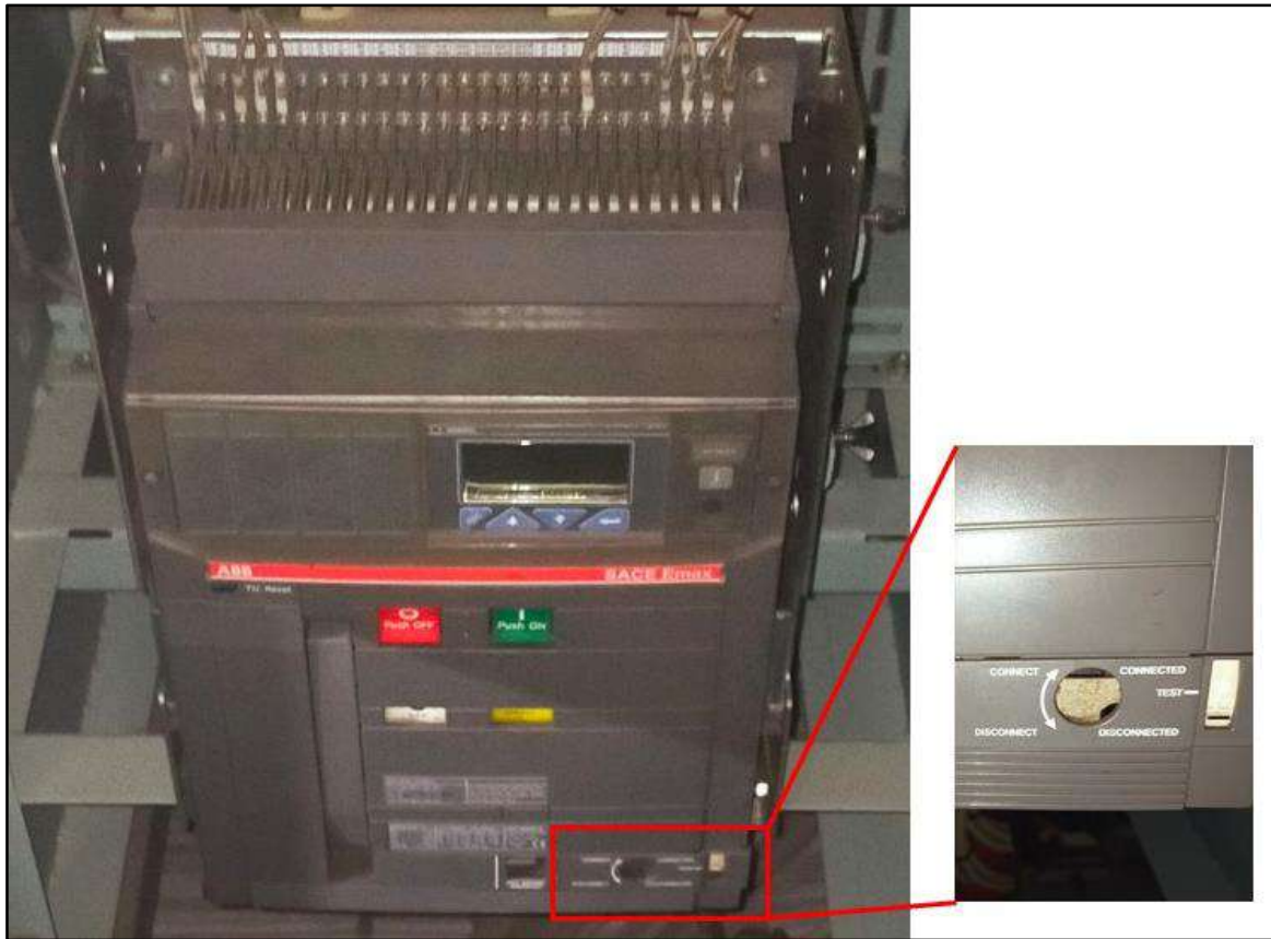
圖 9 ACB 旋鈕開關斷開及連接顯示處
