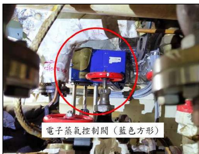
圖 17 電子蒸氣控制閥
