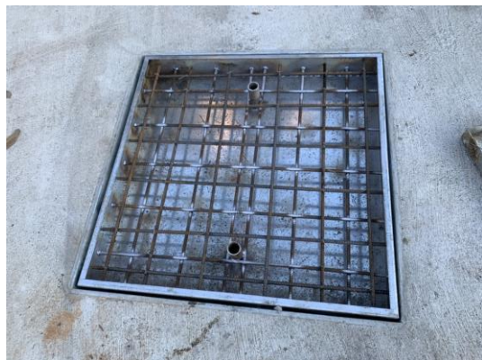
混凝土澆置前
